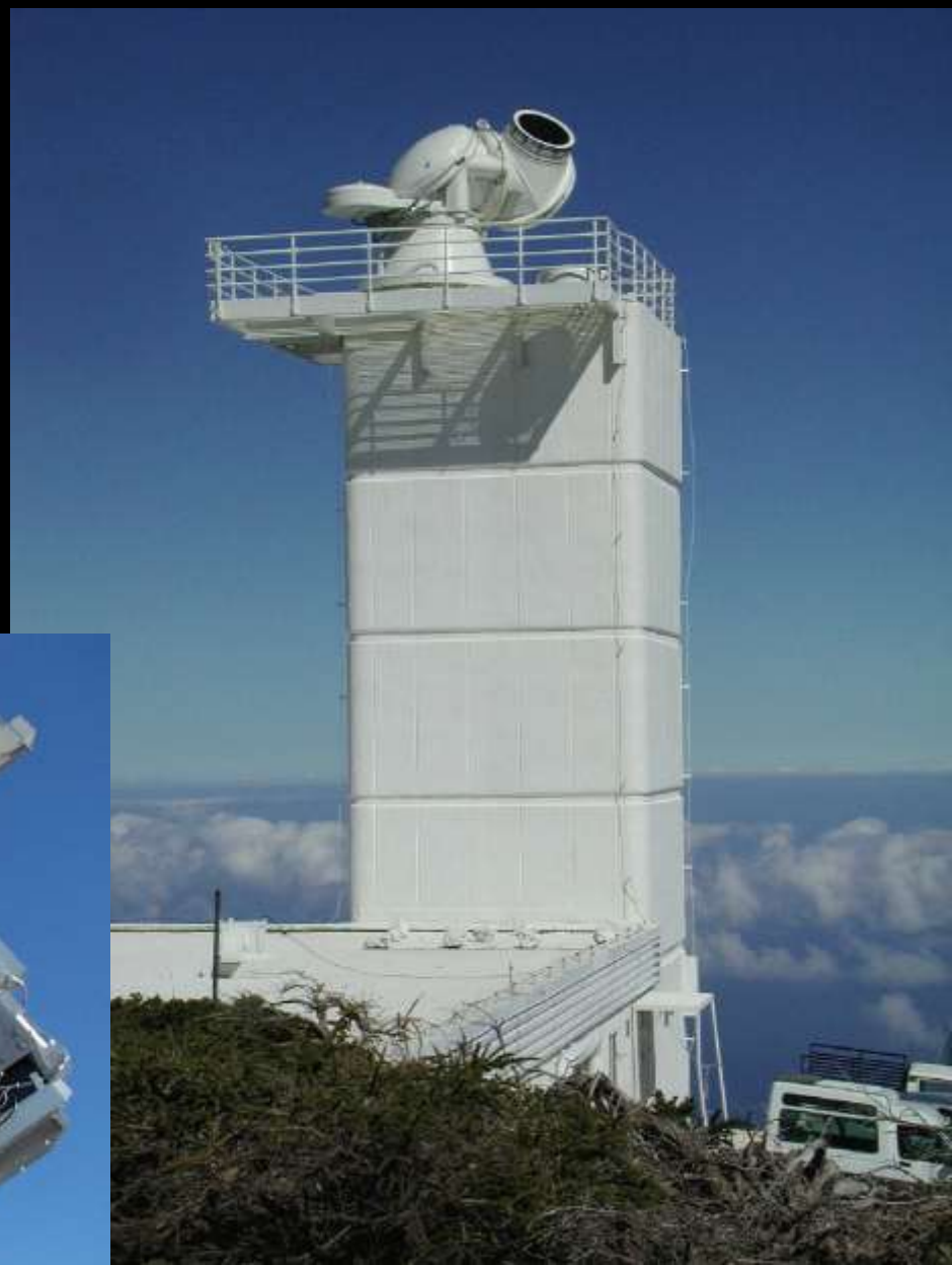
SST télescope solaire de 1 m (Suède)
